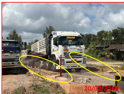
(10) ระบบฉีดน้ำล้างล้อรถบรรทุกอัตโนมัติ
